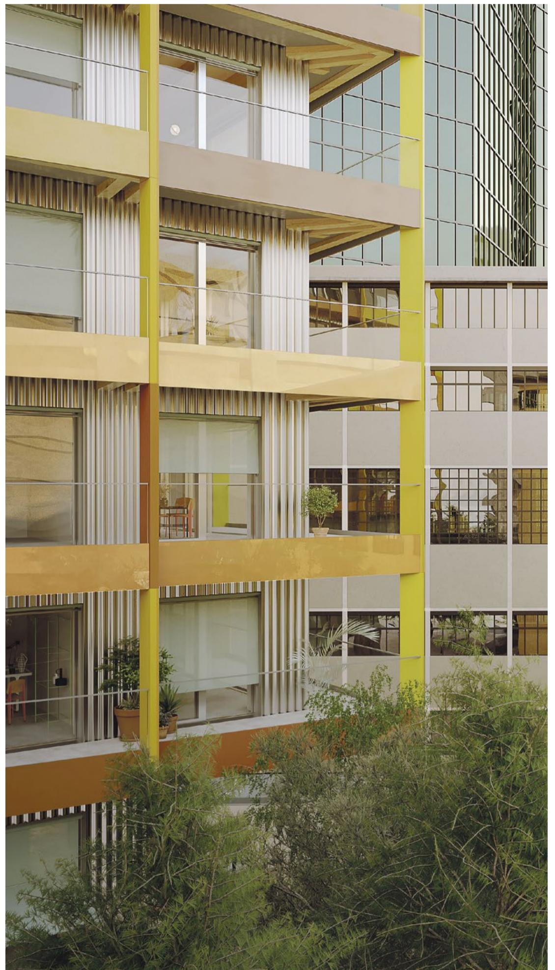
Viele Materialien des Wohnturms können bei seinem Rückbau wieder genutzt werden.
