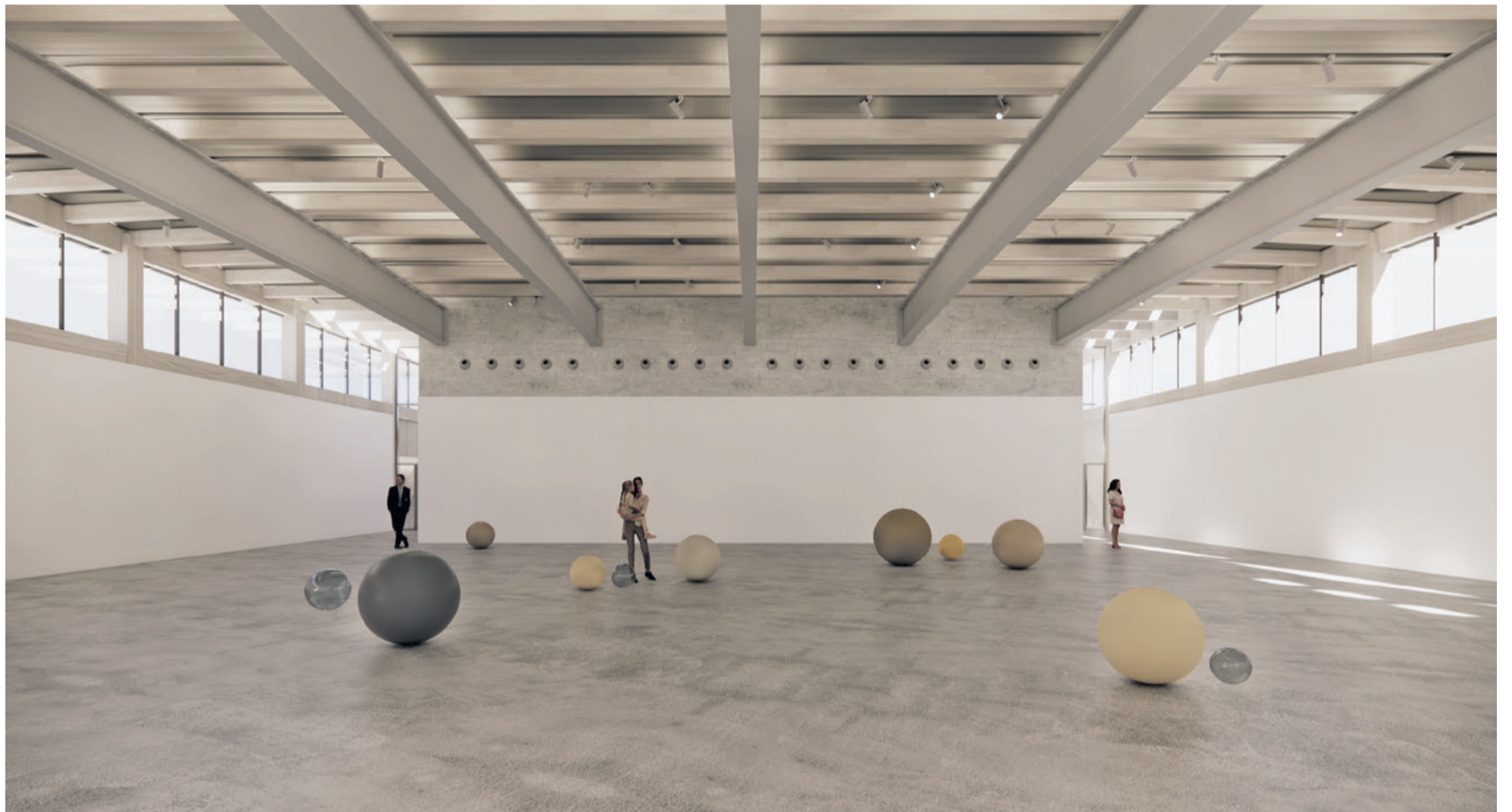
Stahlträger aus den Maaghallen für die Deckenkonstruktion des Kultur-Pavillons.
